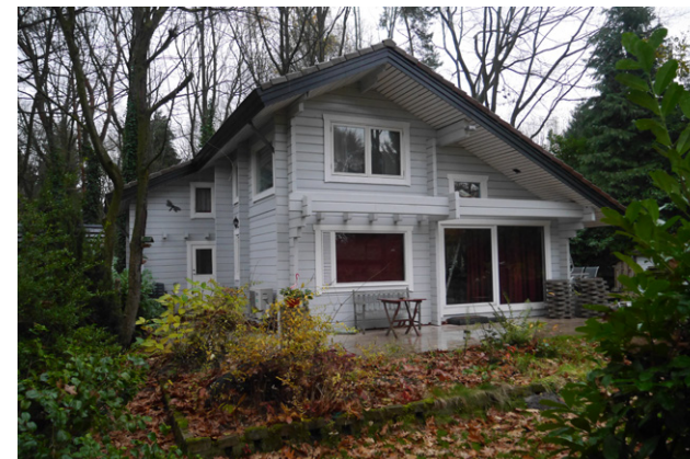
uitbreiding linksboven op de verdieping
