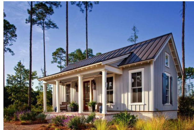
metalen dak, houten bekleding
