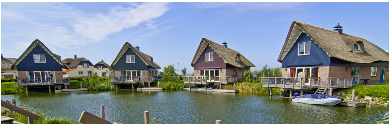
rietten kap, metselwerk begane grond, daarboven hout
